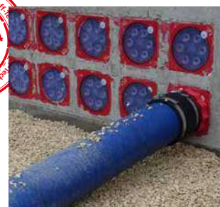
przyłączenie rury osłonowej Hateflex do zabetonowanego przepustu za pomocą pokrywy systemowej KES MA150 D
