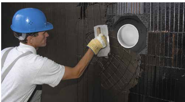
zabetonowany UFR z naniesioną powłoką hydroizolacyjną
