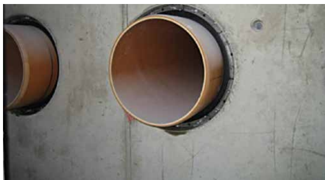
HSD500 G 1x429 b40 A2/EPDM55 napowietrzanie/odpowietrzanie
