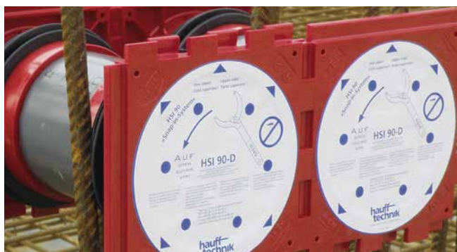
pakiet dwustronnych przepustów HSI90 zamocowany w szalunku
