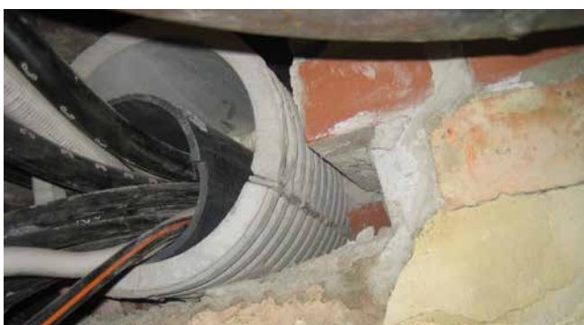
FZRG150/350 montaż w ścianie ceglanej
