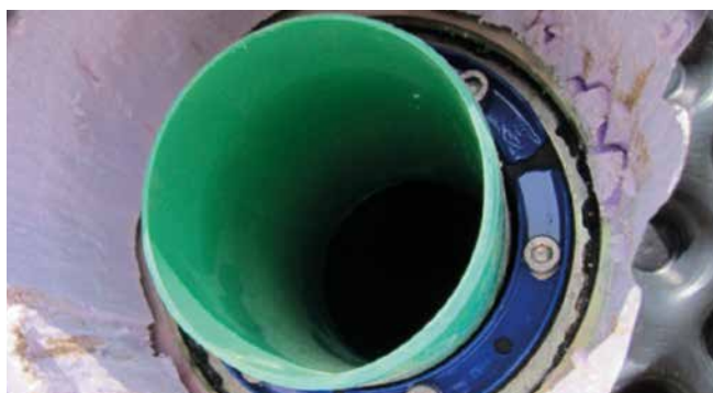
HSD-C 150/110 w ocynkowanym kołnierzu uszczelniająco-mocującym
