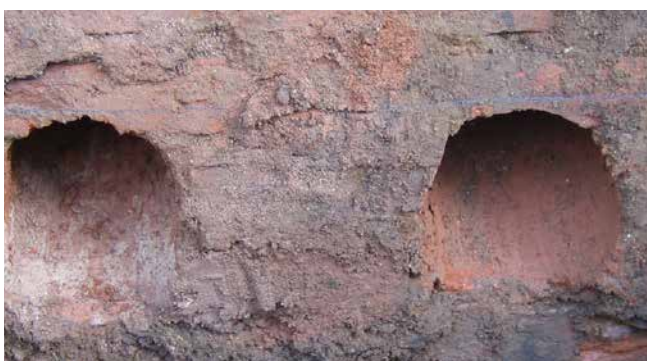
przewiert kątowy wykonany w ścianie z cegły
