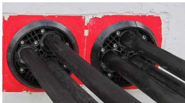
rożne fazy instalacji systemu HSI150 DG 3x24-54
