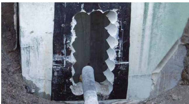
przewód wysokiego napięcia i rury osłonowe muszą zostać dodatkowo uszczelnione w ścianie szybu
