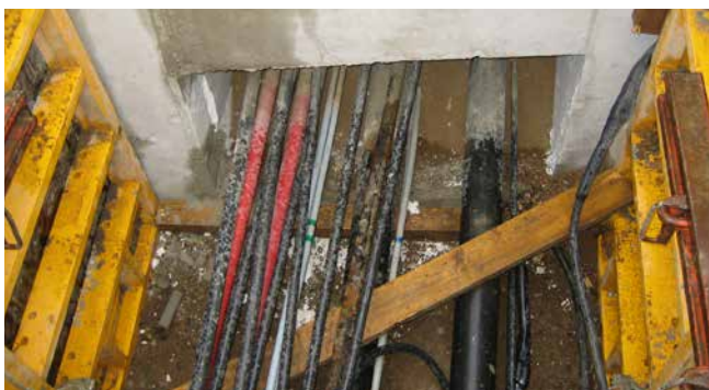
ukośne ułożenie rur i przewodów w otworze
