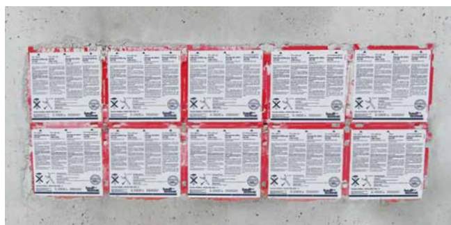
pakiet zabetonowanych przepustów HSI150 po rozszalowaniu
