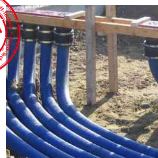
wyprowadzenie kanału kablowego w posadzce za pomocą przepustu HSI150 1x1 KVB150
