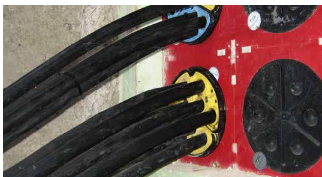
uszczelnienia przewodów oświetlenia ulicznego za pomocą systemu SEGMENTO
