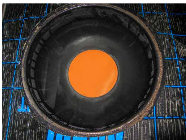
dzięki zastosowaniu dużego czola leja w łatwy sposób można dowieźć system hydroizolacji poziomej
