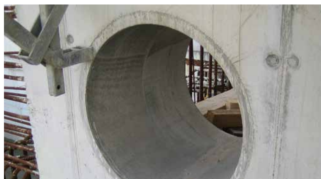
FZR400/300 zabetonowana w zbiorniku oczyszczalni ścieków
