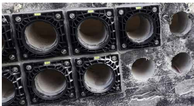
montaż flansz na przygotowanych otworach
