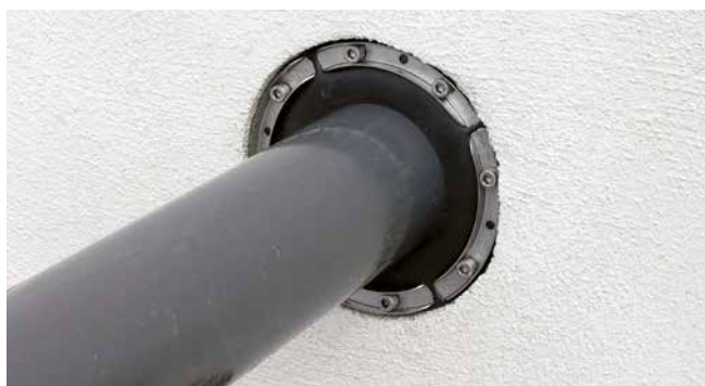
HSD200 1x159 b20 A2/EPDM55– uszczelnienie wprowadzanej rury
