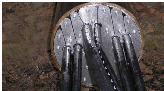
HRD200 G b30 uszczelnienie końca rury stalowej i wychodzących z niej kabli
