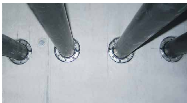
HSD125 1x75 b20 A2/EPDM55 uszczelnienie wprowadzonych rur
