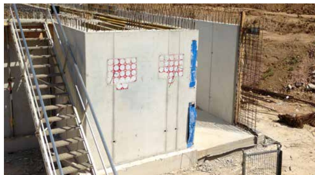
HSI 90 po zabetonowaniu
