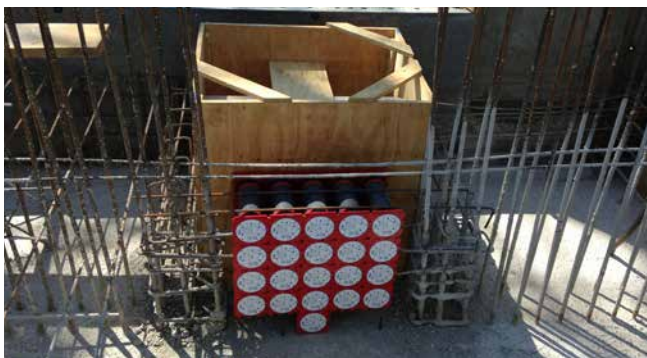
dwustronne przepusty kablowe HSI90 przed zabetonowaniem
